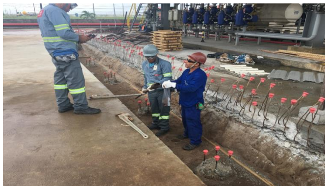
Figura 30 - Avaliação de VOC, através de PID, na profundidade máxima escavada
