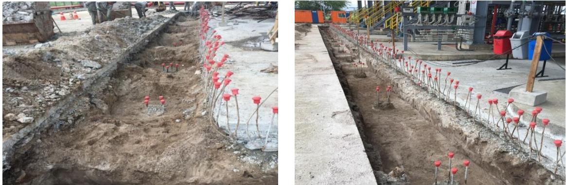
Figura 28 - Escavação manual do solo (profundidade superficial e intermediária)
