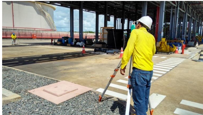
Figura 24 - Execução de topografia voltada para as intervenções civis na plataforma – 1ª. Etapa
