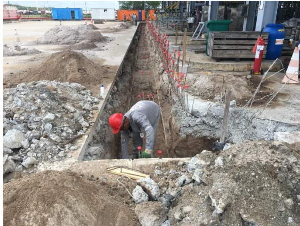
Figura 29 - Execução de concretagem magra (profundidade final das cavas)
