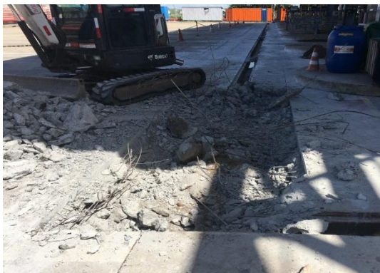
Figura 27 - Demolição do piso da plataforma – 4ª. Etapa
