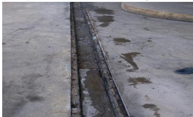
Figura 25 - Limpeza química das canaletas de circulação de efluentes – 2ª. Etapa
